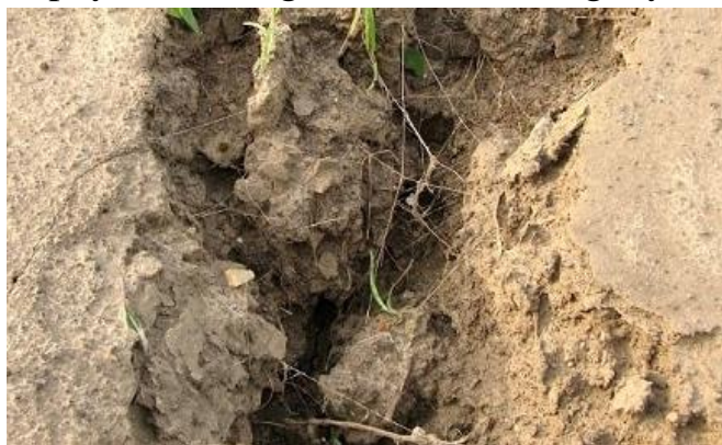
Hình 1: Đất bị xói mòn rửa trôi
